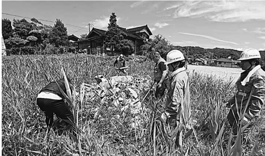
この日はブロックの撤去 酷暑の中の作業となりました
