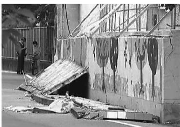
大阪の地震で倒壊したブロック塀
