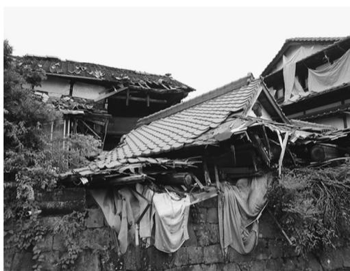
◁台風が多い九州では、重い瓦屋根が多い。しかし震災ではその重みが倒壊被害につながってしまった可能性がある
